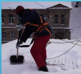
Для очистки крыши от снега и наледи выдайте работникам лопату и скребок с телескопической ручкой. Кроме того, обеспечьте работника, которого допустили работать на крыше, средствами защиты от падения с высоты, специальной одеждой и обувью, защитной каской.
